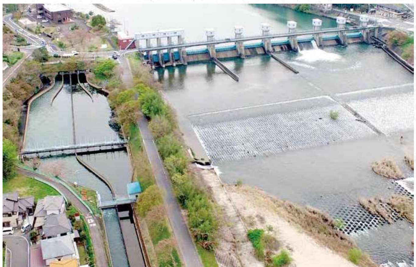
明治本流と頭首工(豊田市水源町地内)
