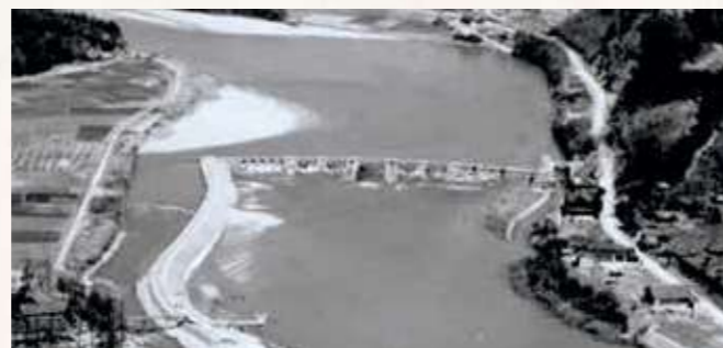
旧頭首工全景
