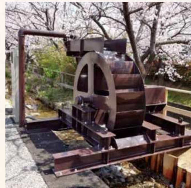
篠目童子発電所(安城市篠目町)
