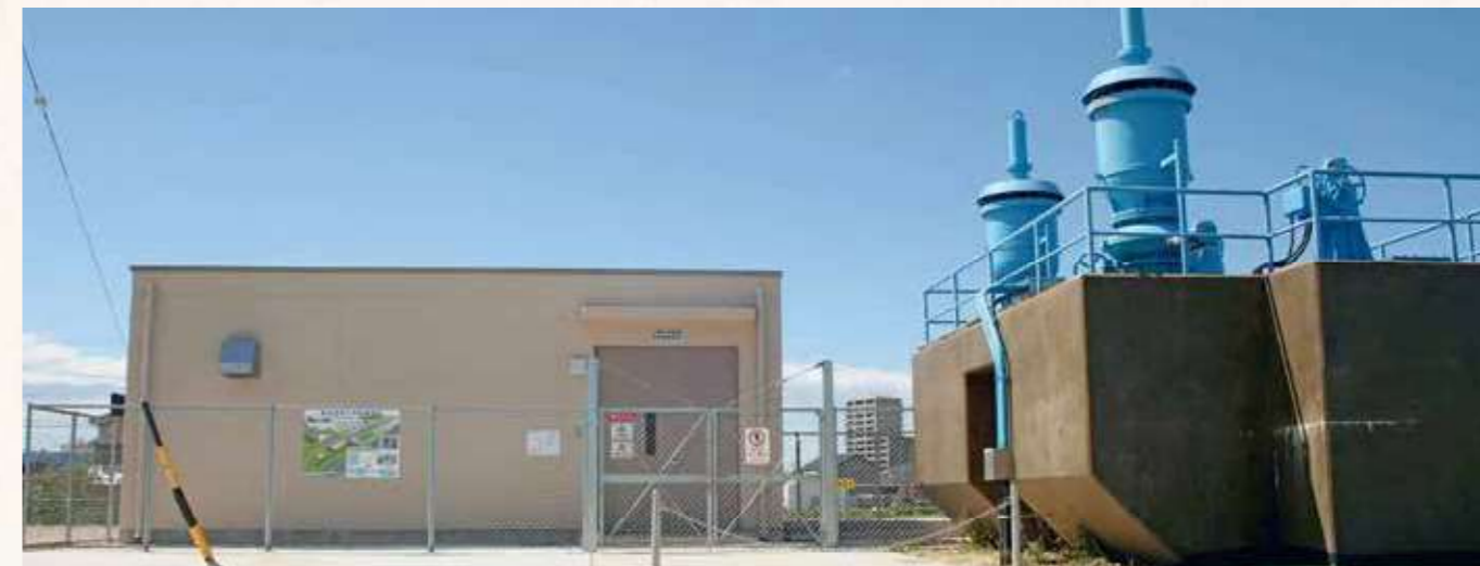
中井筋発電所外観(安城市篠目町)
