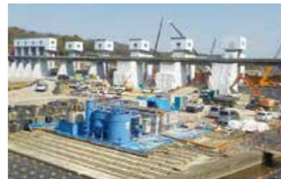
▲頭首工耐震化工事
