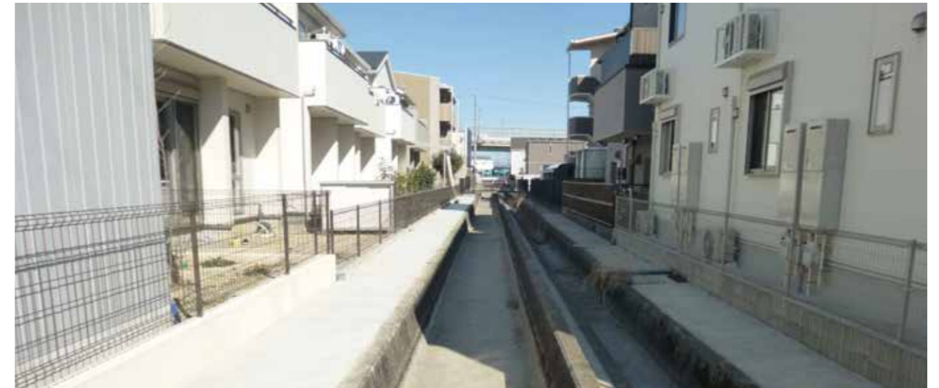
▲築地用水・小山新田用水 防草対策（刈谷市内）
