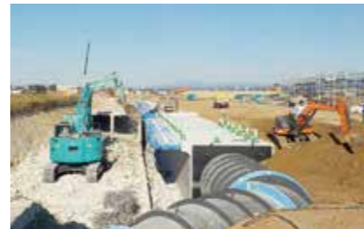
▲明治本流耐震化工事
