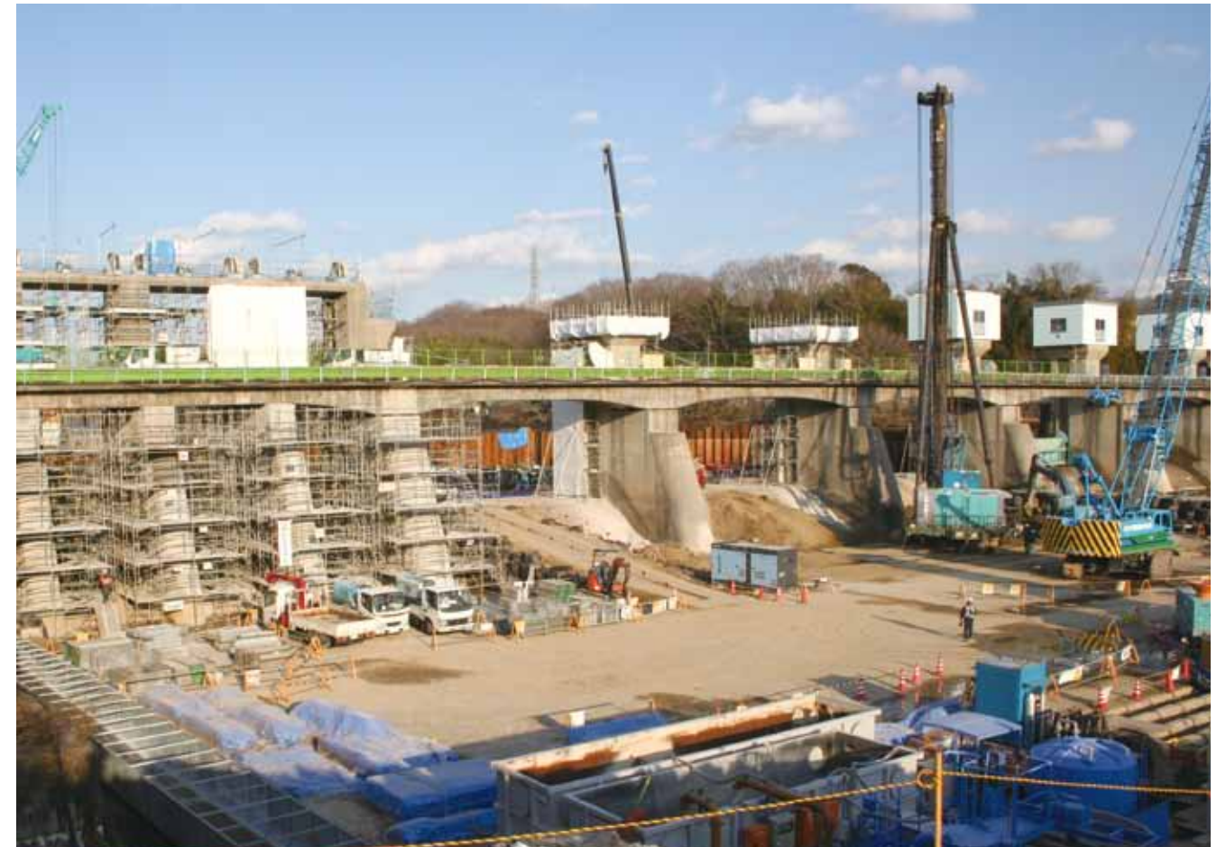
▲頭首工下流部の工事状況（豊田市水源町地内）
