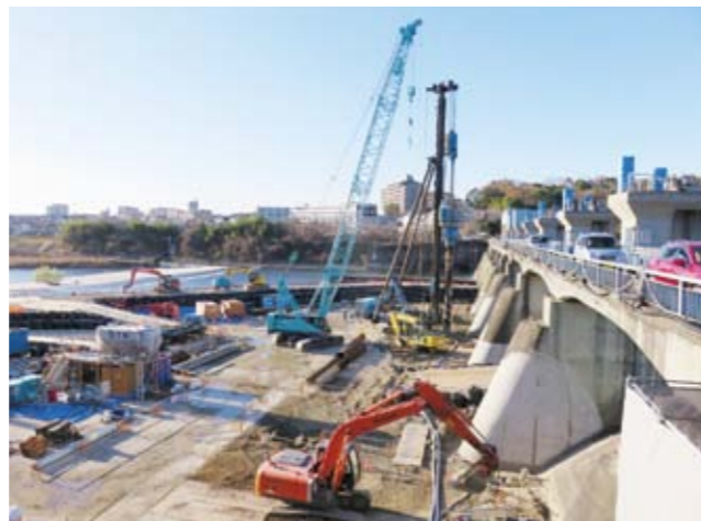
頭首工耐震化工事の状況（豊田市水源町 頭首工下流）
