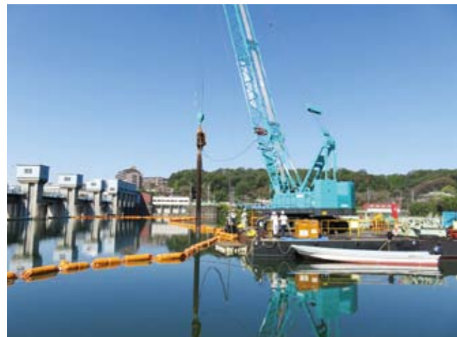
頭首工耐震化工事の状況（豊田市水源町 頭首工上流）
