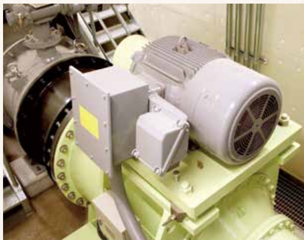
プロペラ水車発電機(中井筋発電所)
