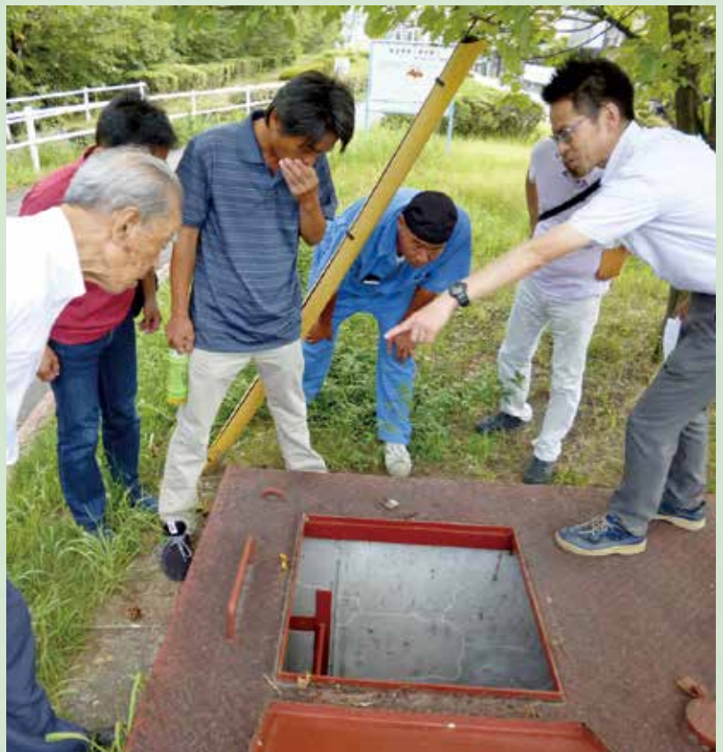
研修で地下のパイプラインを確認
