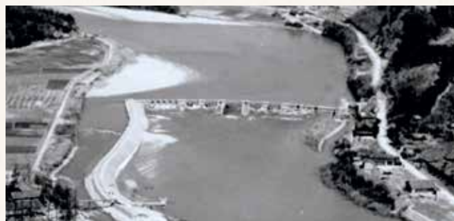
旧頭首工全景
