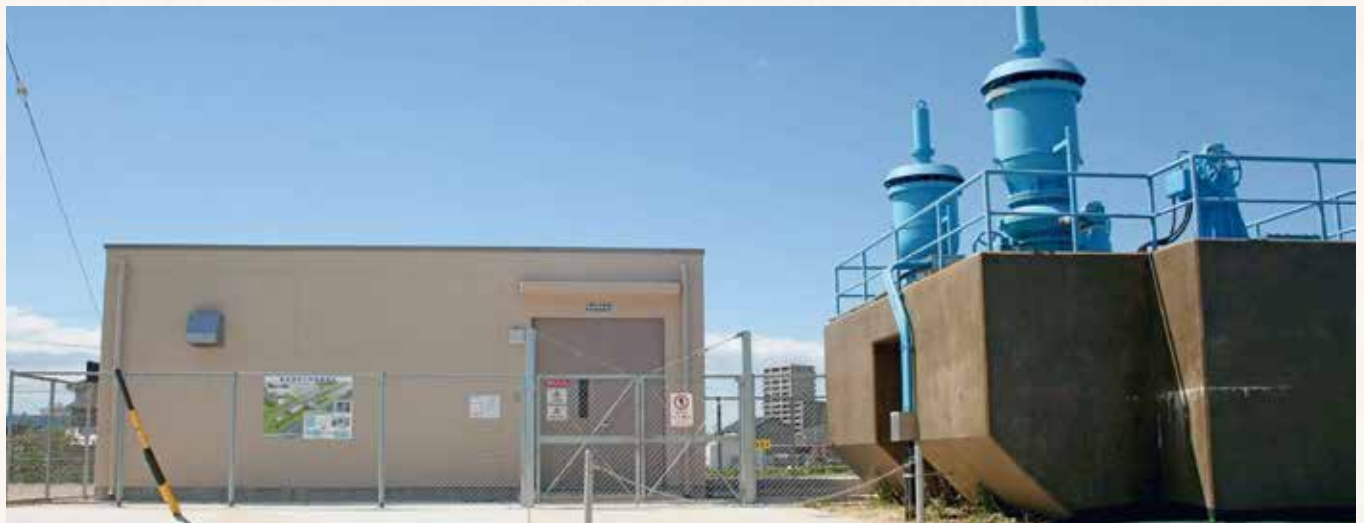
中井筋発電所外観(安城市篠目町)
