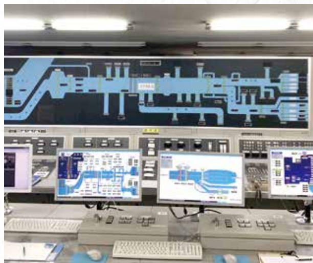
水源管理所 遠方監視制御施設
