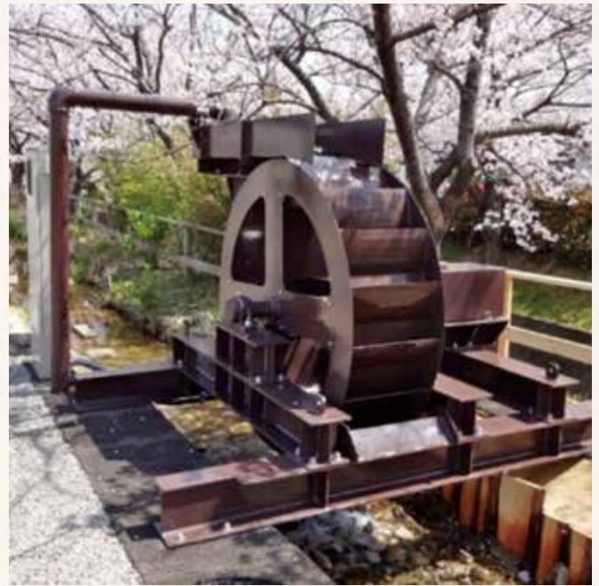
篠目童子発電所(安城市篠目町)
