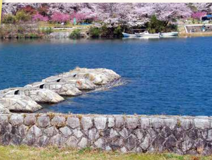
現存する明治用水旧堰堤左岸土砂吐と船通閘門の一部
