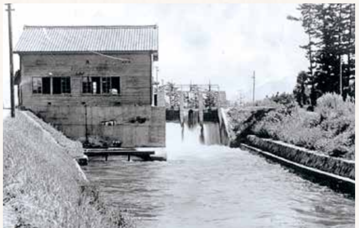
広畔発電所(295KW・240ha かんがい)
