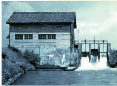
明治用水広畔発電所(昭和11~34年に稼働)上流から下流への落差4mを利用した発電所。現在は制水門となっており、この落差4mを活用することで、ここから下流の管水路方式が実現した。
