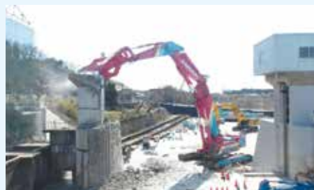
昨年度の本復旧工事（P1堰柱取り壊し）
