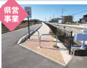
中井筋2期地区：水環境整備
