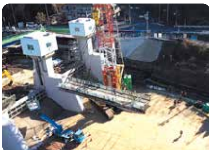
水源橋撤去（堰柱再構築のため）
