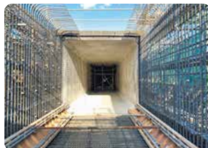
耐震対策（函渠：鉄筋組立）
