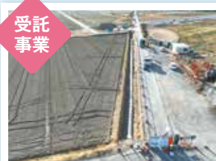
大原地区：大原用水付替工事
