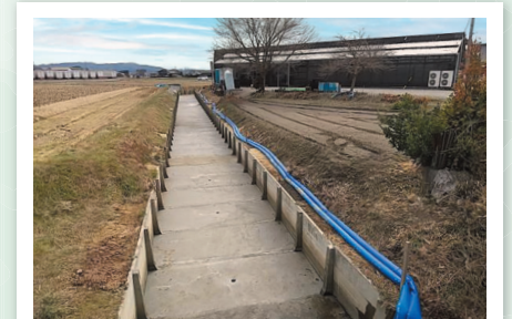
東牧内地区：東牧内支川改良工事
