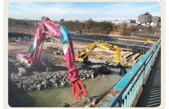
超大型圧砕機による頭首工復旧工事状況
