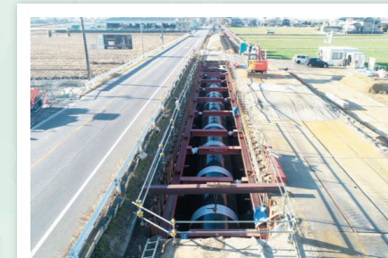
東井筋地区：東井筋布設替工事
