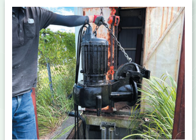
木戸地区：ポンプオーバーホール工事
