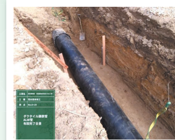
東高根地区：東高根用水改良工事
