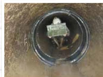
原泉地区(安城市石井町) 農水管φ900止水バンド設置状況
