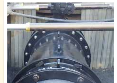
原泉地区(安城市石井町) 制水弁φ900取替状況
