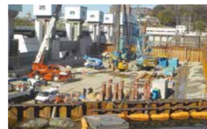
①頭首工の工事実施状況
