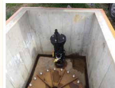
東井筋地区(安城市新田町外) 空気弁φ150取替状況
