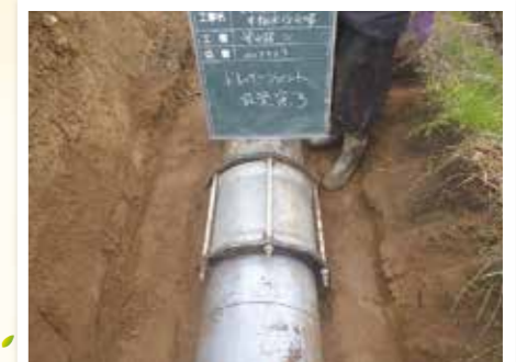
米中地区(西尾市米津町) 農水管φ450布設状況
