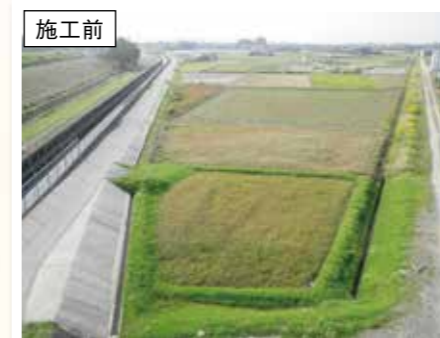
施工前 渡下地区(岡崎市渡町)
