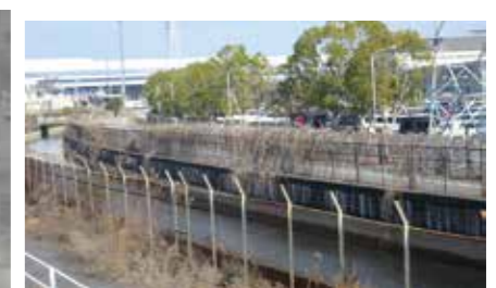
③本流上流部の工事予定箇所
