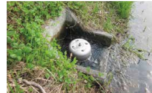
田用給水栓（写真①）
