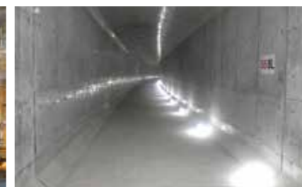
②本流下流部の耐震対策実施後
