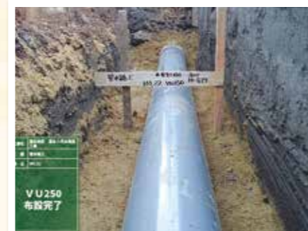
富永地区(岡崎市富永町) 農水管φ250布設状況
