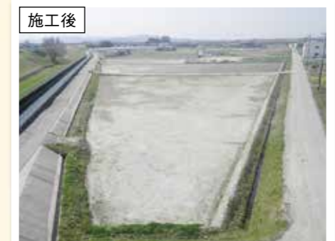
施工後 ほ場内の畦畔が除去され大区画ほ場化されると共に用水はパイプライン化されました。
