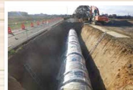
西井筋地区(知立市八橋町)農水管φ1800布設状況
