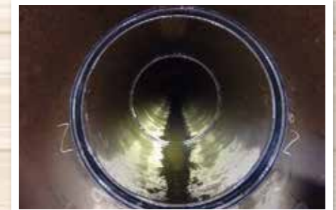
東井筋地区(安城市大東町)φ2400止水バンド設置
