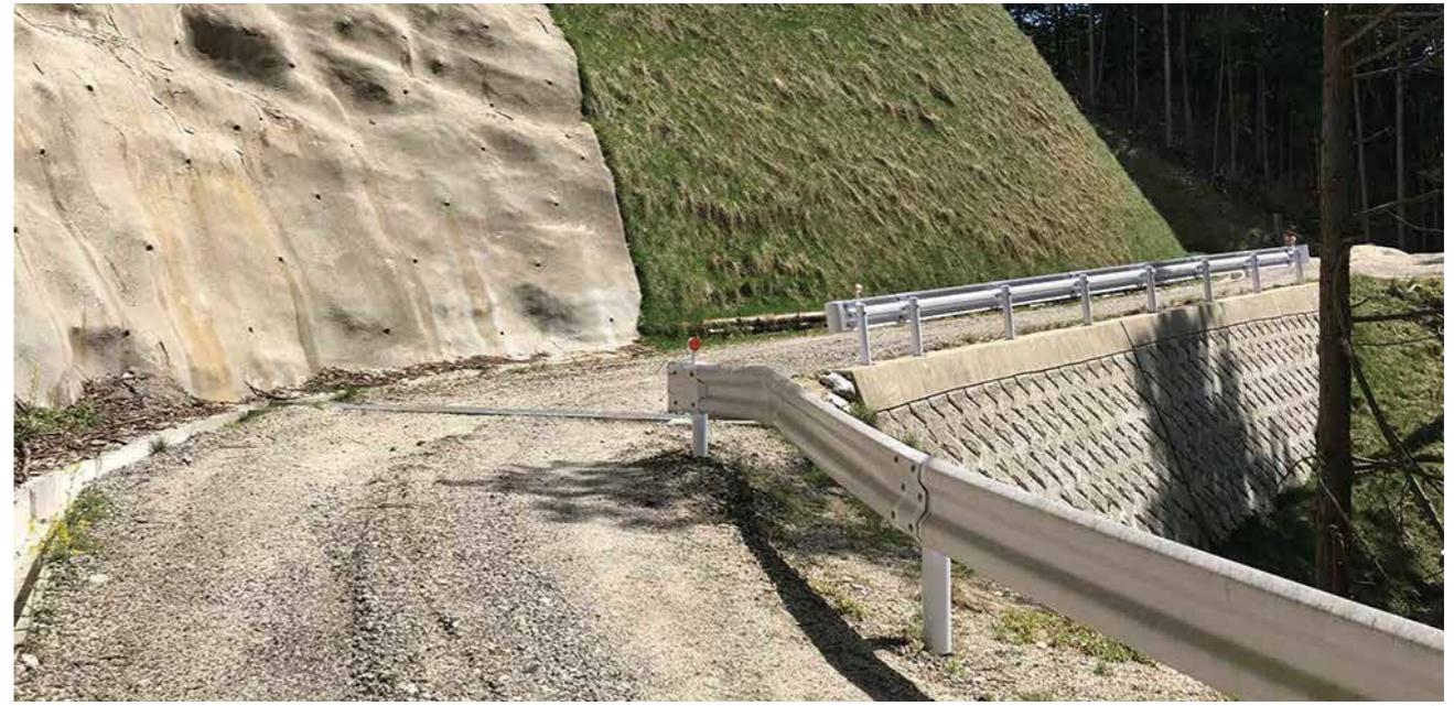
完成した林道
