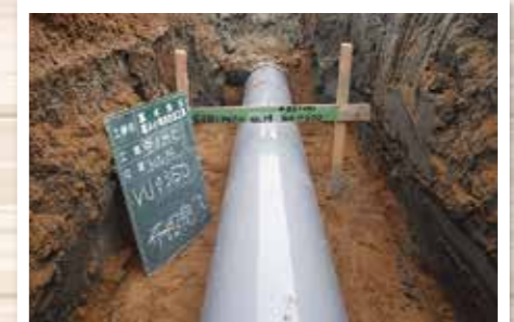
富永地区(岡崎市富永町)農水管φ350布設状況
