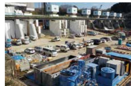
▲明治用水頭首工の工事状況
