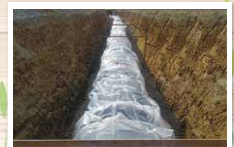
花ノ木地区(安城市和泉町)農水管φ1200布設状況
