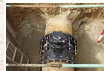
北柳原地区(安城市北山崎町)制水弁φ800取替状況
