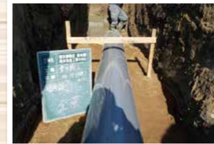
東本郷地区(岡崎市東本郷町)農水管φ350布設状況
