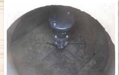
北柳原地区(安城市北山崎町)空気弁φ100取替状況
