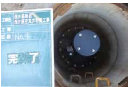
西井筋地区（安城市里町）空気弁φ150取替状況
