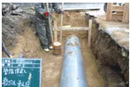
東本郷地区（岡崎市東本郷町）農水管φ400布設状況
