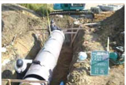
長瀬地区（岡崎市北野町）農水管φ800布設状況
