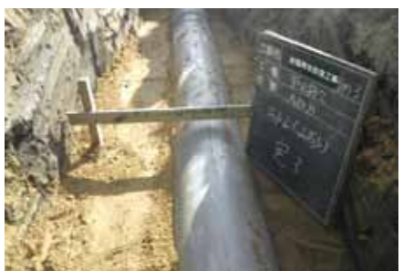
新堀地区（岡崎市新堀町）農水管φ400布設状況
