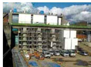
【写真3】頭首工土砂吐の巻立鋼板
