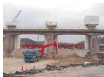
【写真2】頭首工5号洪水吐
