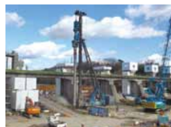
【写真4】頭首工の補強基礎杭
