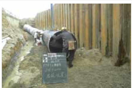
中井筋地区（安城市高棚町）農水管φ1200布設状況
