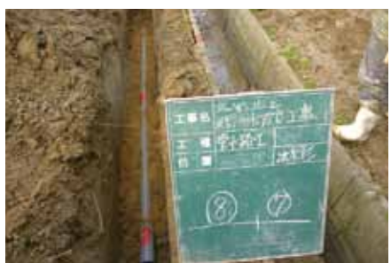
北野地区（岡崎市島坂町）農水管φ250布設状況
