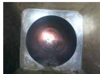
【写真1】国道1号線等の補強鋼管
