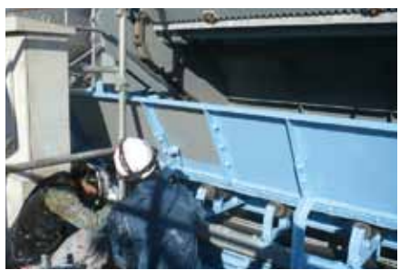
明治幹線地区（豊田市広美町）除塵機塗装状況
