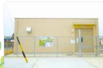
▲中井筋発電所外観
