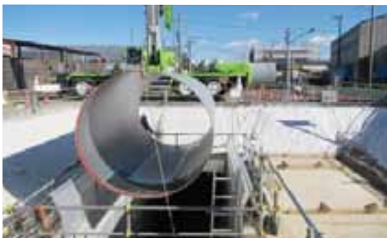
▲明治幹線水路耐震化工事の現況（安城市東栄町地内）
