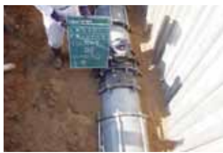
小畔1号地区(岡崎市北野町) 制水弁φ500取替状況
