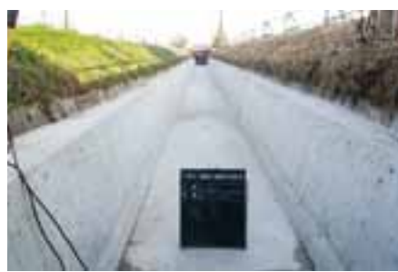
鷺蔵地区(安城市里町) 用悪水路改良
