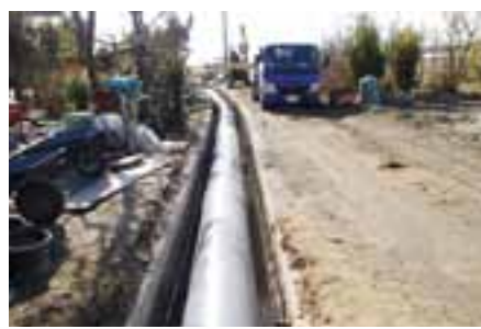
西富地区(岡崎市西本郷町) 管水路φ500布設状況
