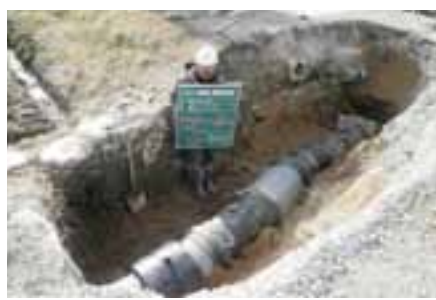
新堀地区(岡崎市新堀町) 農水管φ400布設状況
