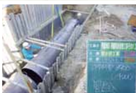
西徳地区(安城市桜井町) 農水管φ900布設状況
