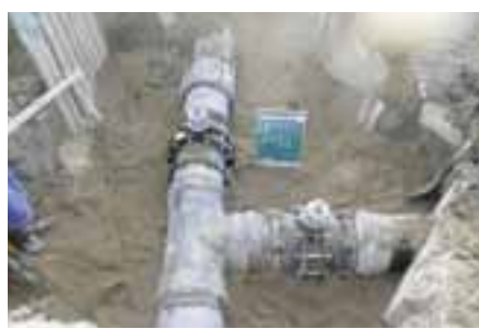
御神田地区(豊田市吉原町) 制水弁φ450取替状況
