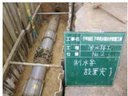
子竿地区（刈谷市小垣江町） 制水弁φ450取替状況
