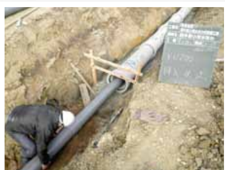
和会地区（豊田市和会町） 塩ビ管φ200布設状況
