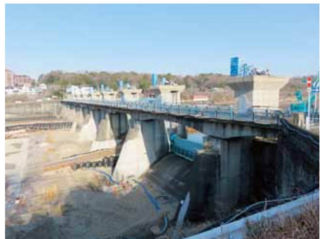
ゲート上屋の撤去、下流からの仮設道路（頭首工下流）
