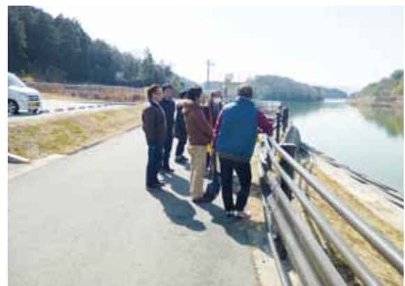
斎宮調整池（三重県多気郡明和町）
