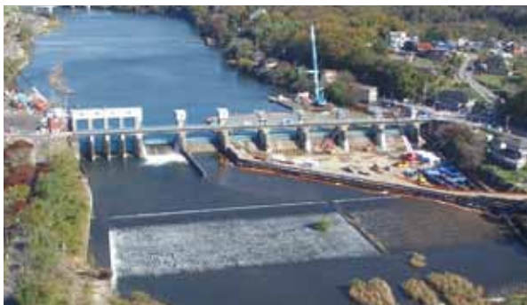
▲頭首工耐震化工事の状況（豊田市水源町地内）
