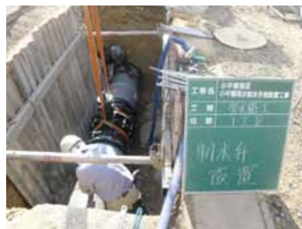
小中根地区（高浜市小池町） 制水弁φ500取替状況
