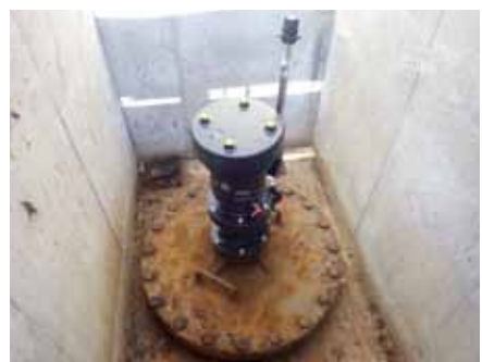
中井筋地区（安城市池浦町） 空気弁取替状況
