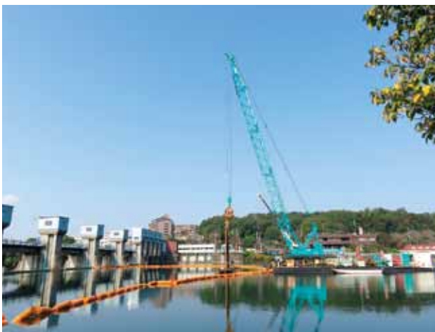
頭首工耐震化工事の着手（頭首工上流）
