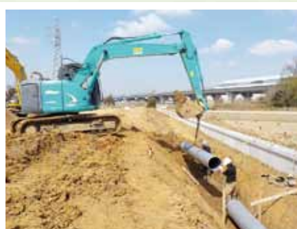
藤池地区（安城市里町） 塩ビ管φ450布設状況
