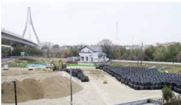
▲頭首工耐震化工事資材の製作状況(豊田市渡合町地内)
