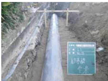
小望地区（岡崎市島坂町） 塩ビ管φ450布設状況
