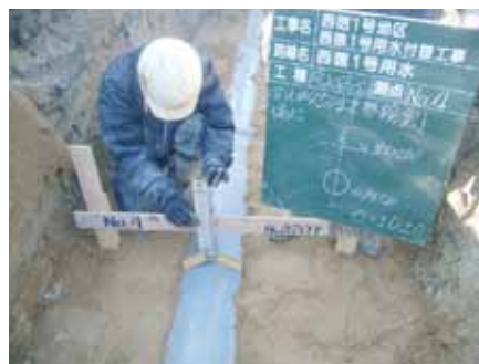
西徳1号地区（安城市桜井町） 塩ビ管φ450布設状況
