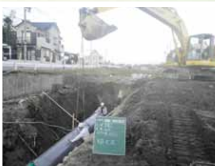
長瀬地区（岡崎市北野町） FRPM管φ800布設状況
