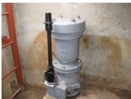
中井筋地区（安城市池浦町） 空気弁φ150取替
