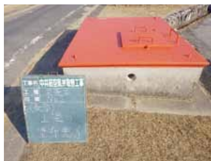
中井筋地区（安城市池浦町） ピット塗装
