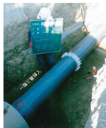
西荒井地区（碧南市立山町） 農水管保護状況
