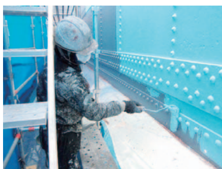
明治頭首工地区（豊田市水源町） 洪水吐ゲート塗装状況
