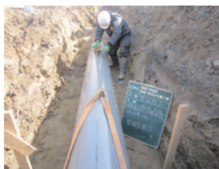
西徳1号地区（安城市桜井町） 塩ビ管φ400mm布設替状況
