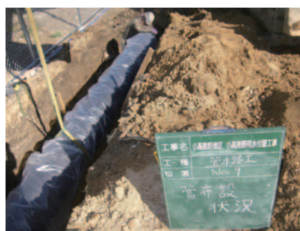
小高熊野地区（刈谷市熊野町） ダクタイル鋳鉄管φ500mm布設状況
