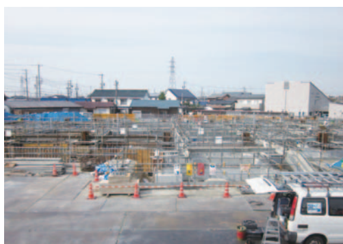
▲新明治用水会館改築工事状況
