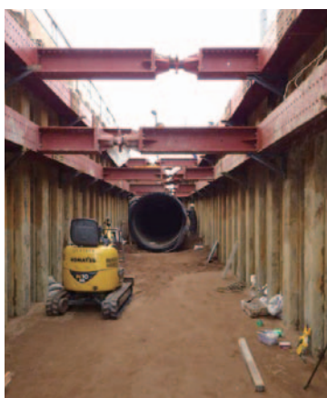
西井筋地区（安城市里町） ダクタイル鋳鉄管φ2,100mm布設
