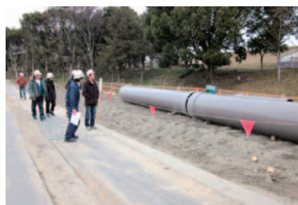
県営かんがい排水事業 村高地区(安城市小川町地内) PRPM管φ900mmの用水管の前に
