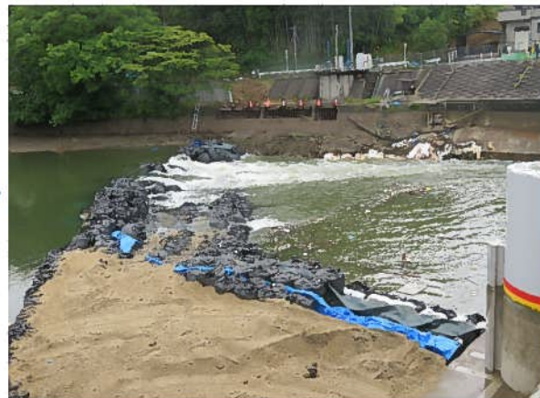
No.6 R4/6/6 明治用水頭首工漏水箇所状況 豊田市水源町地内
